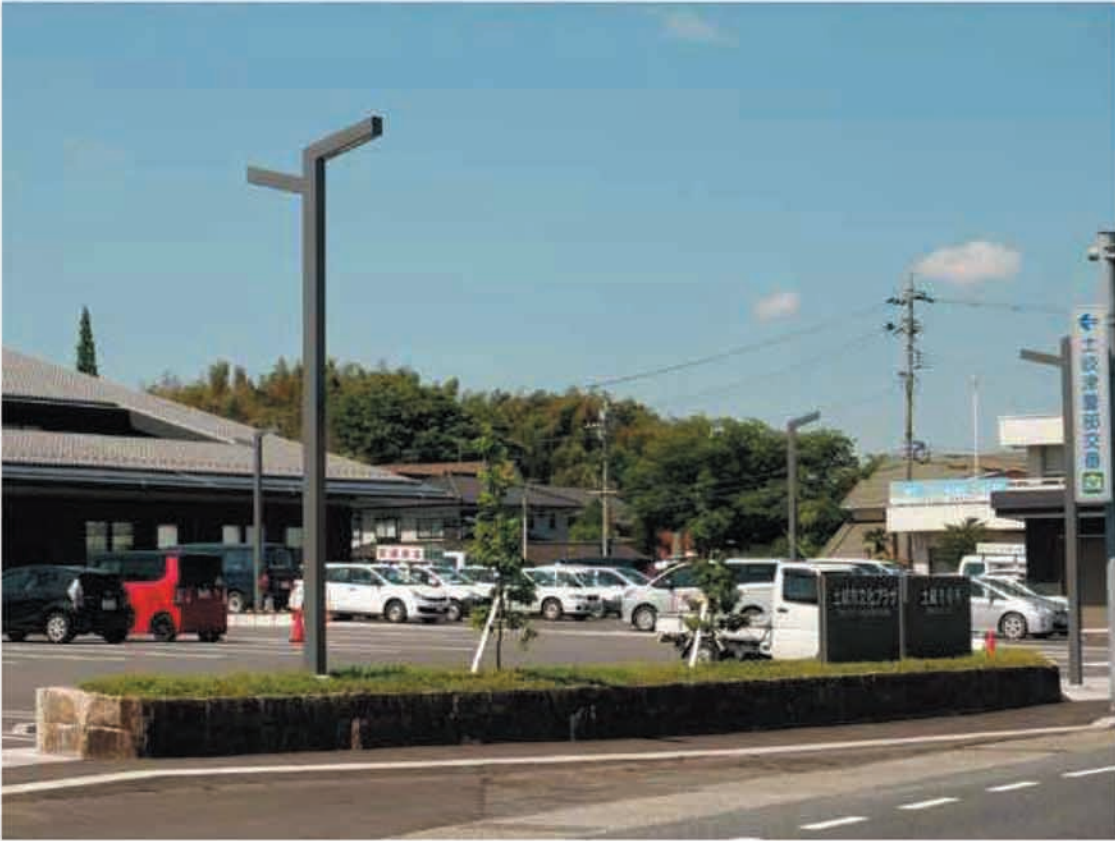
土岐庁舎駐車場／岐阜県土岐市 施主：土岐市役所
