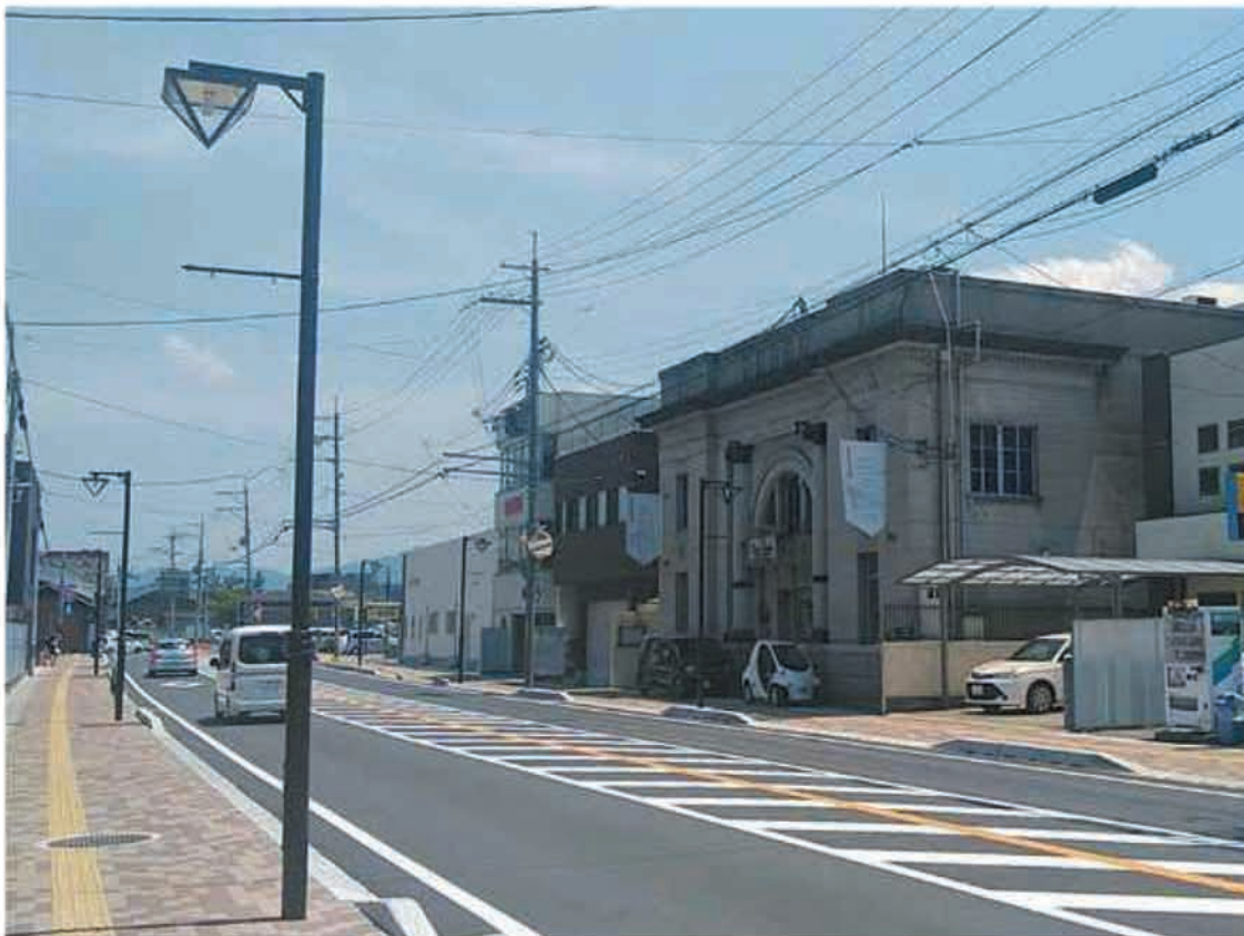
畝傍駅前通り線／奈良県橿原市 施主:奈良県
