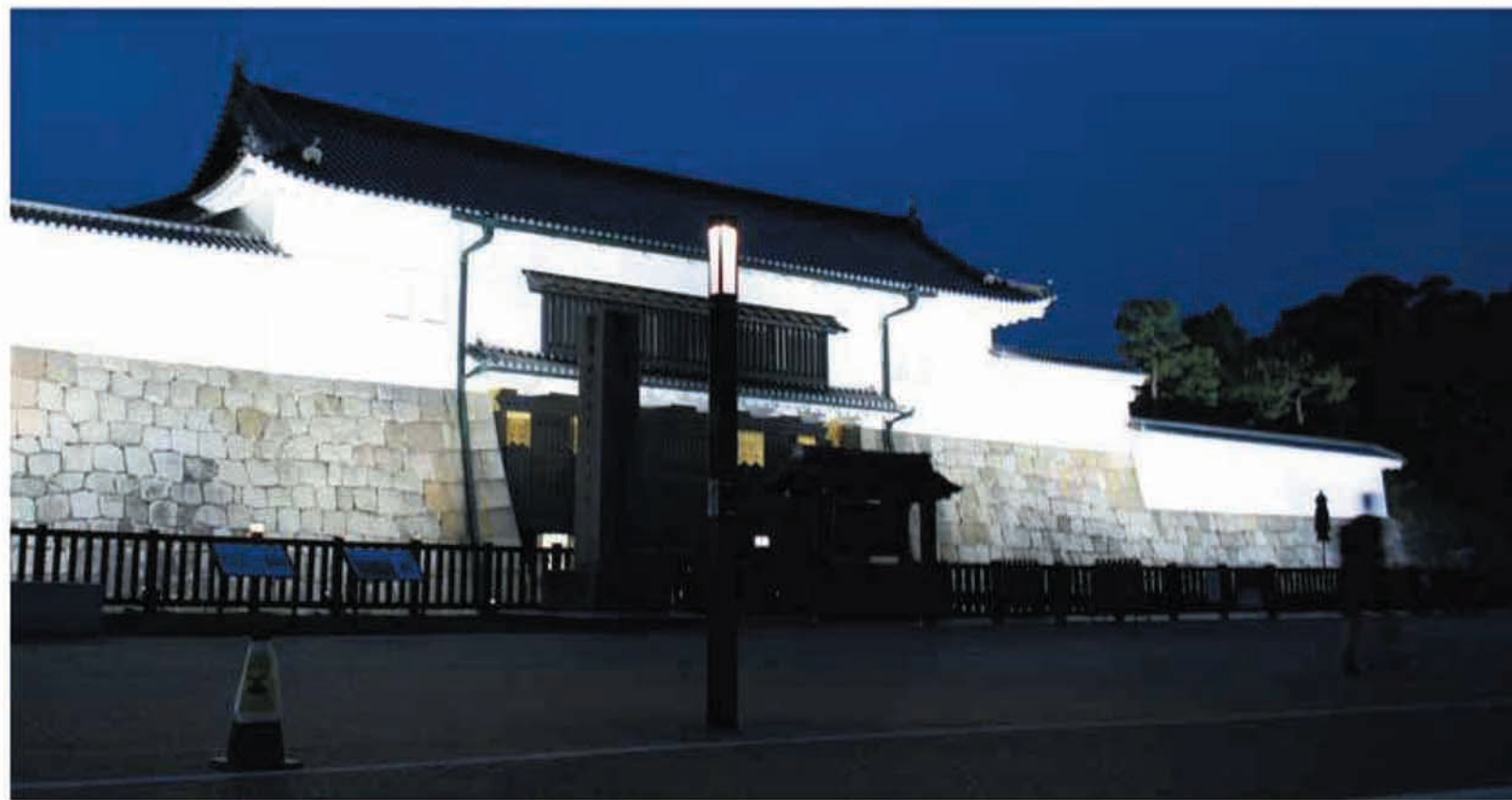
二条城外周／京都府京都市 施主：京都市役所
